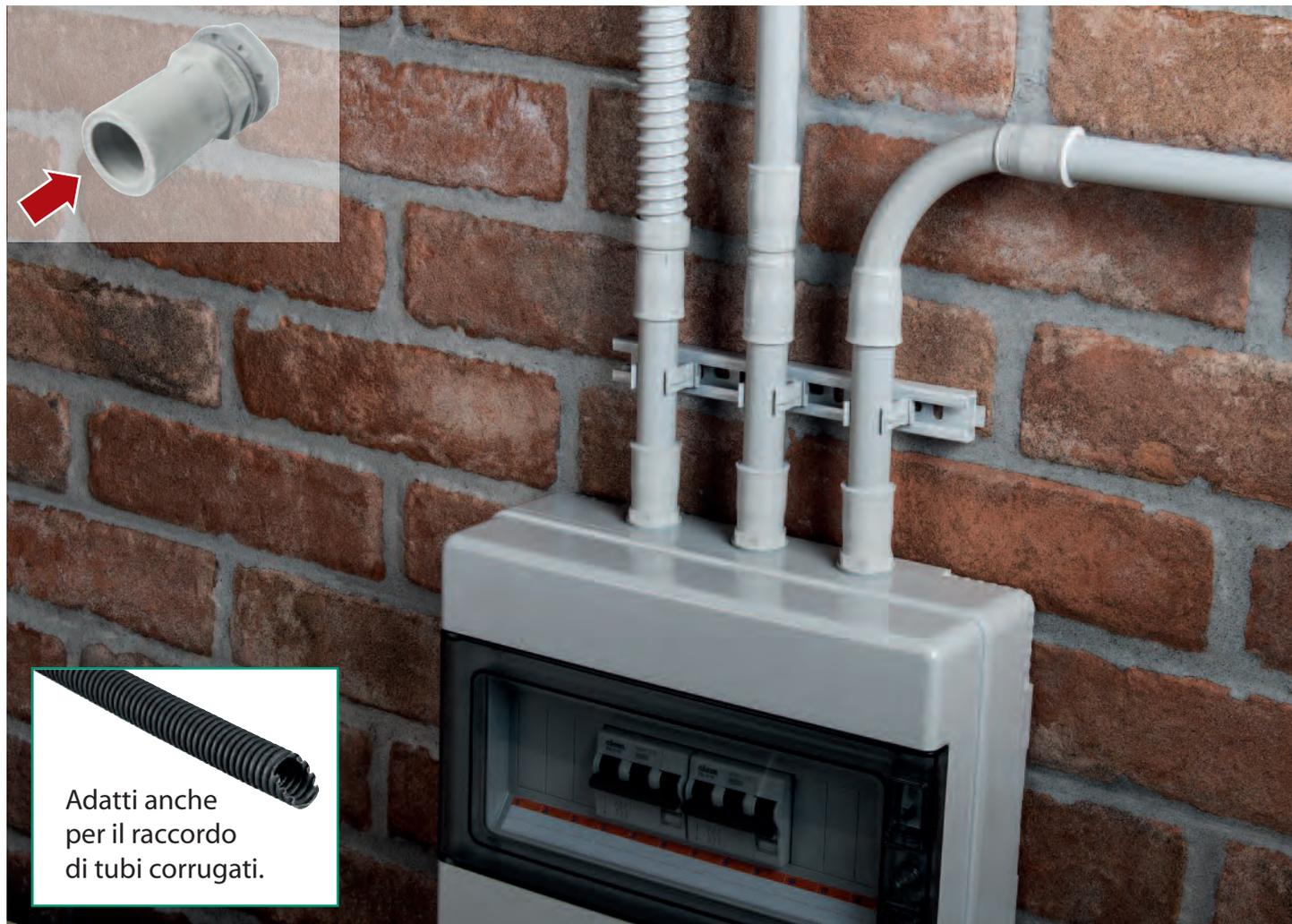
I raccordi stagni per tubo rigido serie SECURITY System sono classificati con il grado di protezione IP67 sull'intera gamma.
