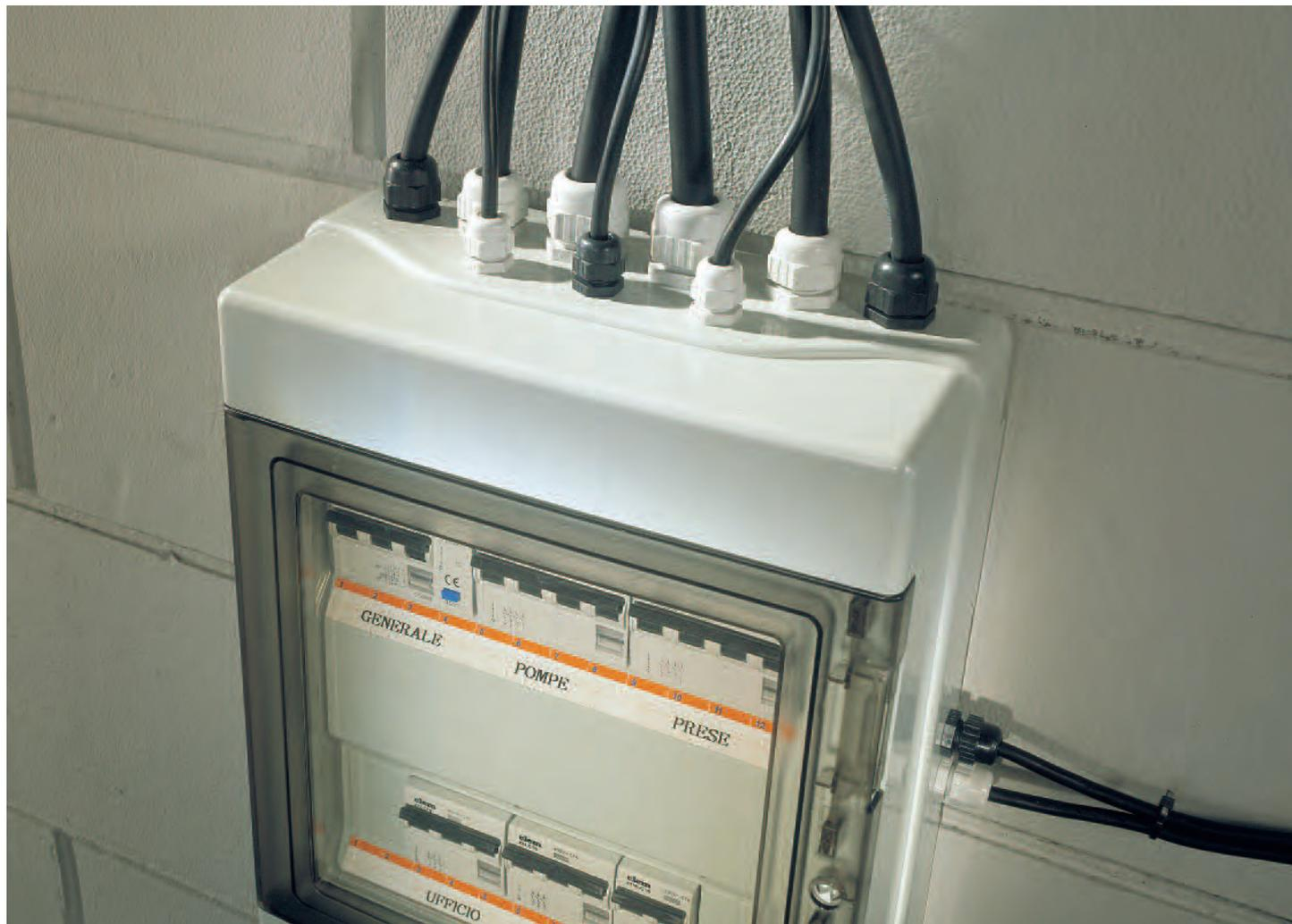
I pressacavi ELETTRICANALI sono realizzati in tecnopolimero nylon 6.6 rigido di elevata qualità, resistente agli oli e grassi minerali, adatti per impieghi gravosi in ogni ambito.
